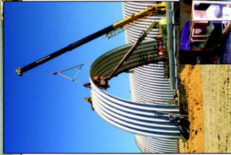
Montaje de un edificio Steelmaster
