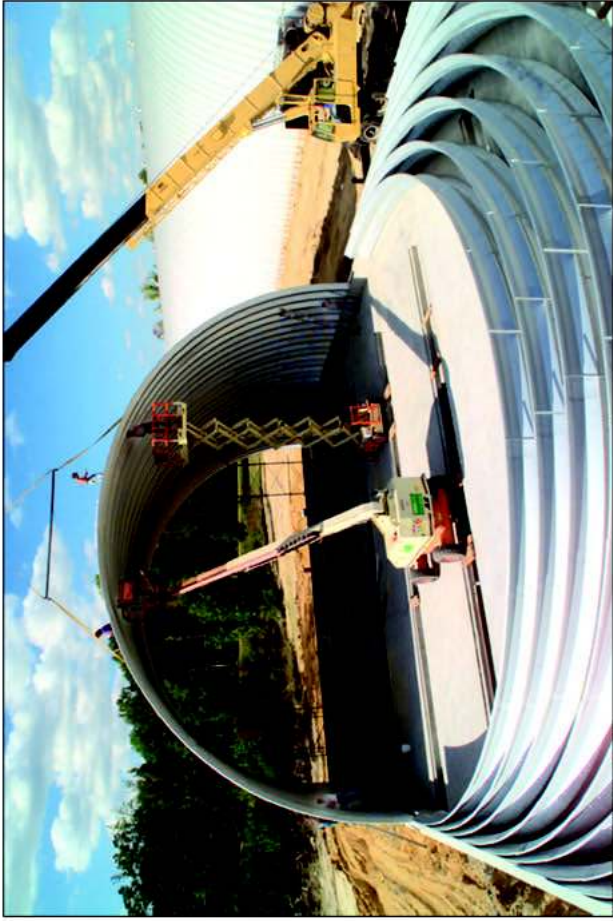
Montaje de un edificio Steelmaster
